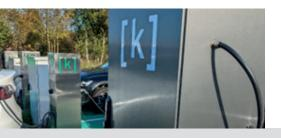
Bei [k]nord ® wurden sowohl Schnellladesäulen (DC-Ladepunkte), als auch Standardstationen (AC-Ladepunkte) installiert. Das optimierte Laden mehrerer Fahrzeuge zeitgleich steht hier im Vordergrund.
